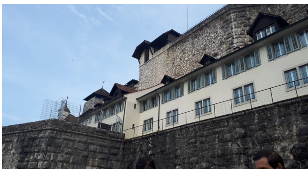
Aussenansicht Kantonales Jugendheim Aarburg (Foto: Vreni Kunz)
